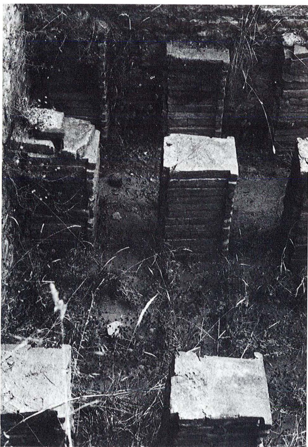
Fig. 3. — Utilisation de briques claveaux dans la construction de pilettes à Mirobriga.
