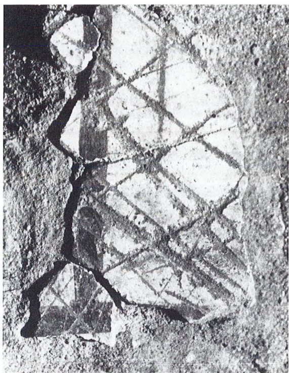
Fig. 14. — Fanum II, rainurage de l'enduit.
