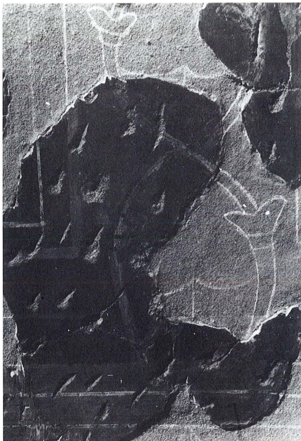
Fig. 15. — Basilique, piquetage de l'enduit ancien.
