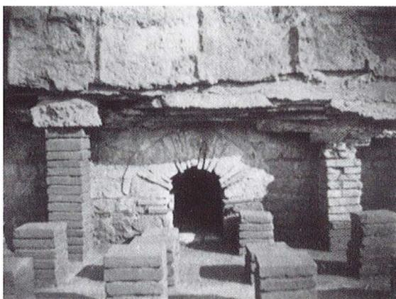
Fig. 4 : Chamiers : conduit d'évacuation des gaz chauds sous la piscine 10 des thermes de l'est (cliché Ch. Durand, Musée du Périgord).
