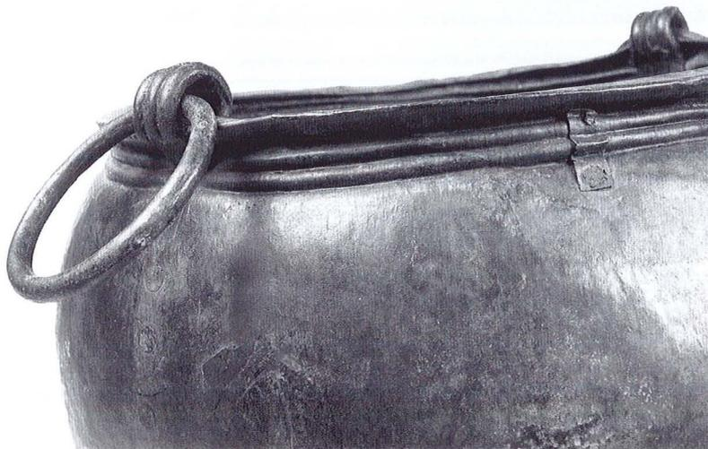
*Fig. 6 : Le chaudron d'Ouzilly-Vignolles. Détail montrant l'assemblage du bord consolidé par deux bandes rivetées (photo Ch. Vignaud, Musée de Poitiers).*
