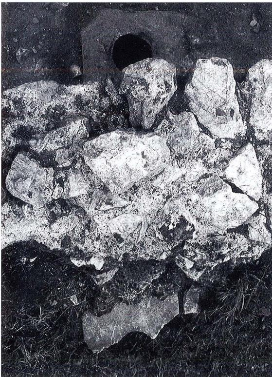
Fig. 17 : Dalles de support d'un des mâts de velum.
