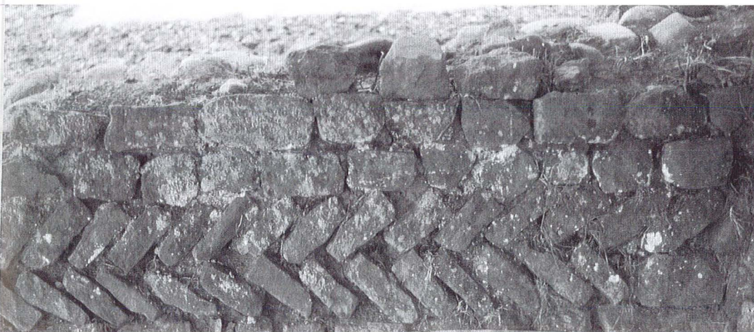
Fig. 15. Vue de l'appareil en opus spicatum de la paroi ouest de la piscine (cliché A. B.).
