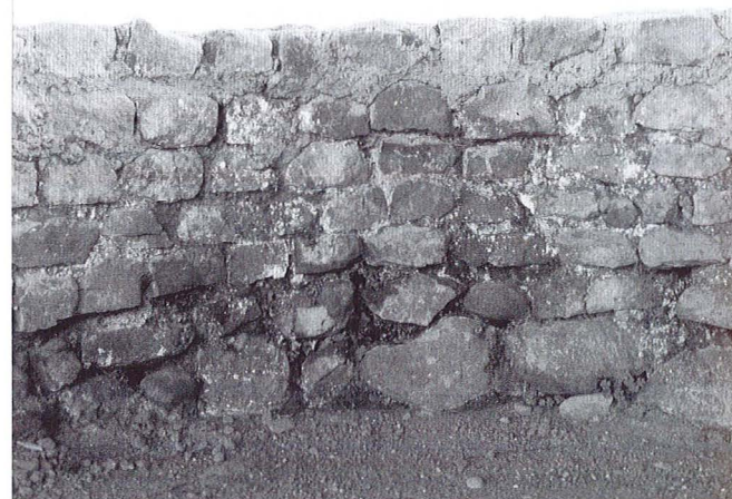
Fig. 14. Vue de l'appareil du mur de la schola labri du caldarium (3) (cliché A. B.).
