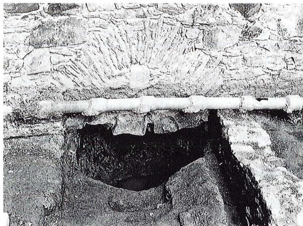
Fig. 3. — La base du mur, l'arc de décharge et la cavité aménagée.
