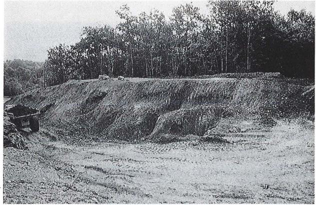
Fig. 6. — Après l'enlèvement des remblais, le front de taille en gradins de la mine antique à ciel ouvert apparaît dans l'aurière nord (côté filon).
