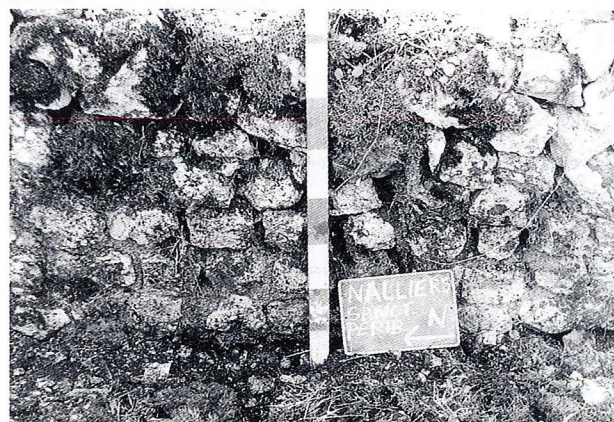
Fig. 9. — Nalliers-le-Bourg. Parement extérieur du mur ouest du péribole du sanctuaire. La partie inférieure montre trois lits de petits appareils, visibles hors-sol.
