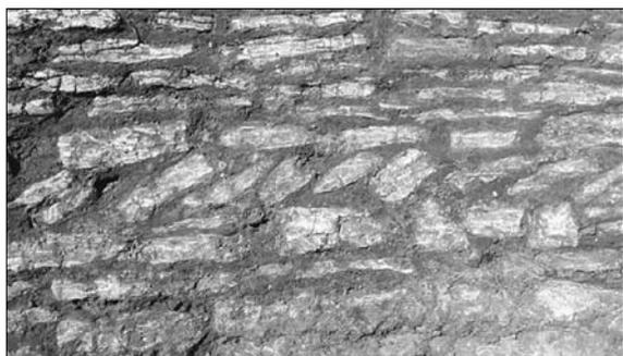
Fig. 12. Vue de détail du parement en arête de poisson du four St.5.
