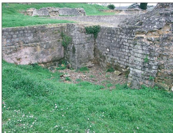
Fig. 48. L'arc latéral ouest du *caldarium*, le mur méridional de la chambre de chauffe 30 recouvert de son enduit (cl. A. Bouet).
