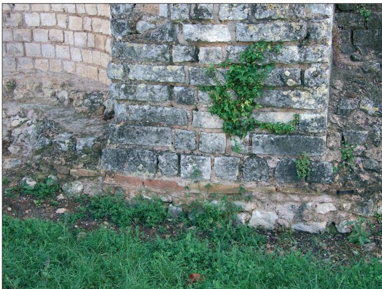
Fig. 17. Assise de réglage à la base du mur de façade sud des thermes (cl. A. Bouet).
