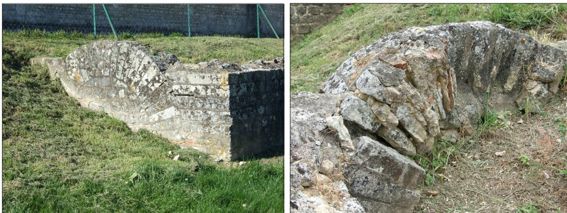
Fig. 18. Arc de décharge pour le passage de l'égout sous le mur stylobate de la palestra. À gauche, face sud, à droite, face nord (cl. A. Bouet).
