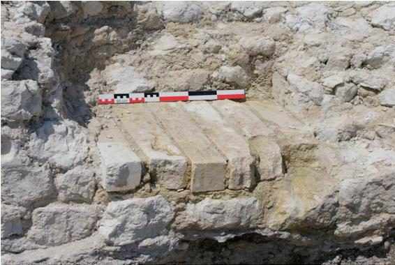
Fig. 34. Sommier ST 72 d'arc de voûte en blocs sciés (fouilles J. Mousset, cl. J. Gaillard).
