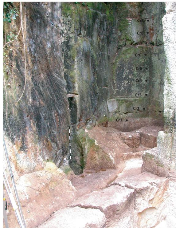
Fig. 2. La carrière de Crazannes, à *Champ Loiseau*. À gauche. le puits antique tranché verticalement par l'exploitation de la carrière ; À droite. la série des 9 prélèvements effectués verticalement tous les 50 cm sur le front de taille afin de réaliser le référentiel de la pierre de Crazannes (fouilles et cl. J. Gaillard).
