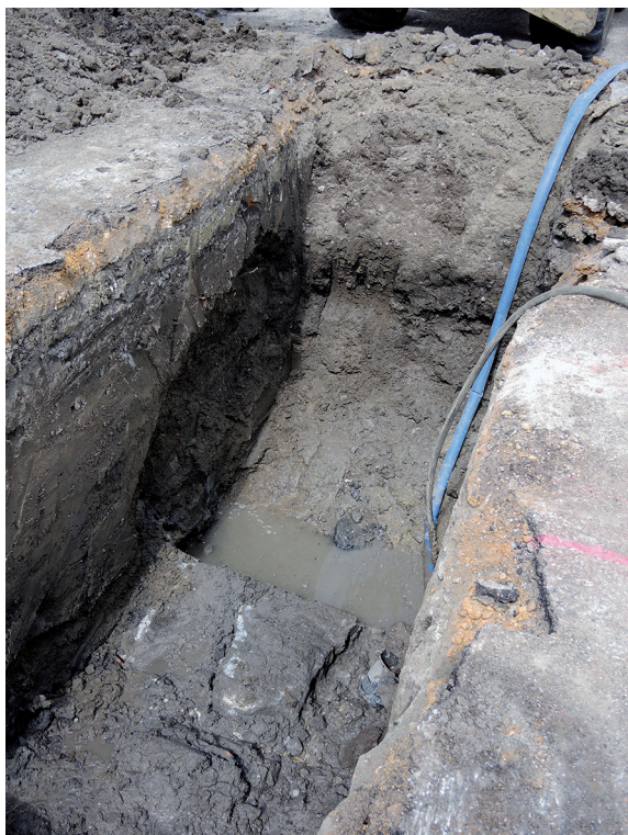
Fig. 8. Vue du possible caniveau sud en cours de dégagement (cl. D. Hourcade).
