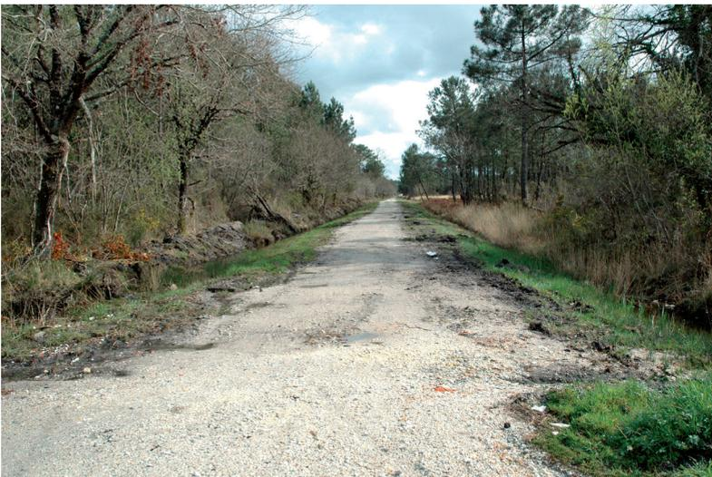
Fig. 5. Listrac-Médoc, la Passe des Fontenelles, à hauteur de Sescouzes. Le chemin, qui doit franchir une lande mal drainée, est d'une largeur importante (11 m), assis sur une levée de grave encadrée de fossés que l'on devine remplis d'eau. Vue prise du nord, 27 mars 2014. Cl. F. Didierjean.
