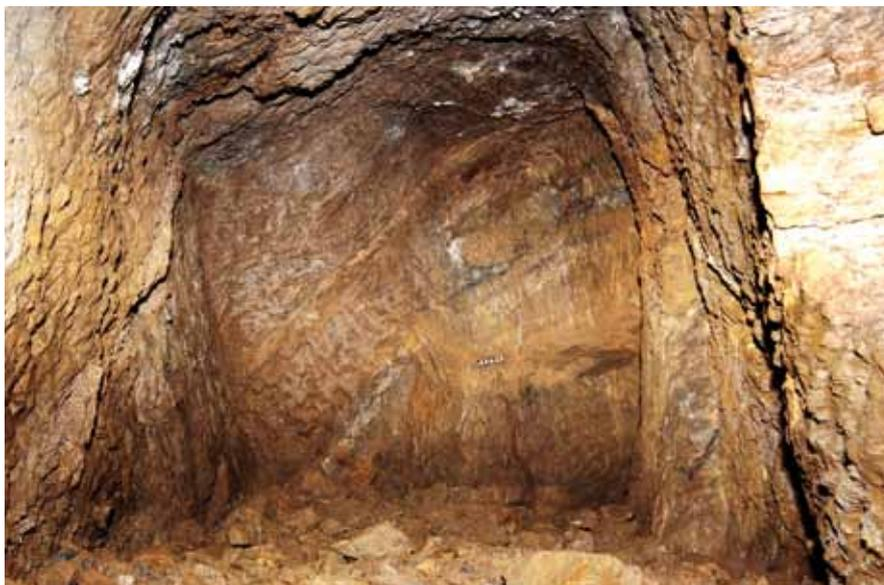
déblais stockés le long des parois, et bien entendu la galerie rectiligne orientée nord-sud d'une longueur de 65 m (largeur : 1,10 m ; hauteur de 2 à 3 m) qui fait aujourd'hui office d'entrée et de sortie. Ce sont là autant de témoignages d'un autre type d'organisation des travaux souterrains. Quelles sont les raisons de ce changement ? Nous verrons que la mine de Bouco-Payrol (réseau nord) présente un exemple similaire.
