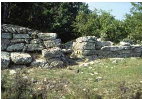
Fig. 29. Rempart et poterne d'inspiration méditerranéenne de l'éperon barré de La Granède (Millau, Aveyron). Fin du II e siècle a.C.
