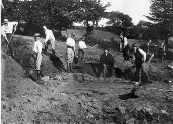
Fig. 13. Vue de la fouille réalisée en 1922 sur l'oppidum de Montmerlhe (Laissac, Aveyron) (d'après Al Canton Laissac , 2000, p. 29).
