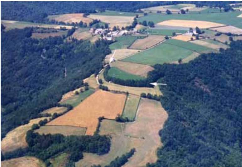
Fig. 14. Vue aérienne du système de fortification méridional de l'oppidum de Centrès (Miramont, Aveyron).
