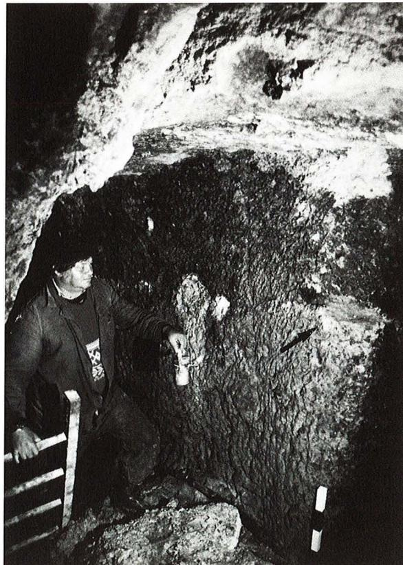
Au Țarina, des vestiges de plusieurs mines romaines sont aujourd'hui le plus souvent inaccessibles. Ainsi, il y a, à 10 m au-dessus de la sole principale actuelle (dans les filons 81/1), plusieurs ouvertures et dépilages. On remarquera plus spécialement une galerie en pente, dans laquelle on descend, sur 15 m de longueur, par une série de marches taillées dans la roche. On ne peut assurer qu'il s'agit là d'un travail romain, mais seulement le conjecturer.
