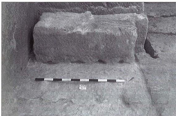
Fig. 7a. Prise de coin sous un bloc en place.
