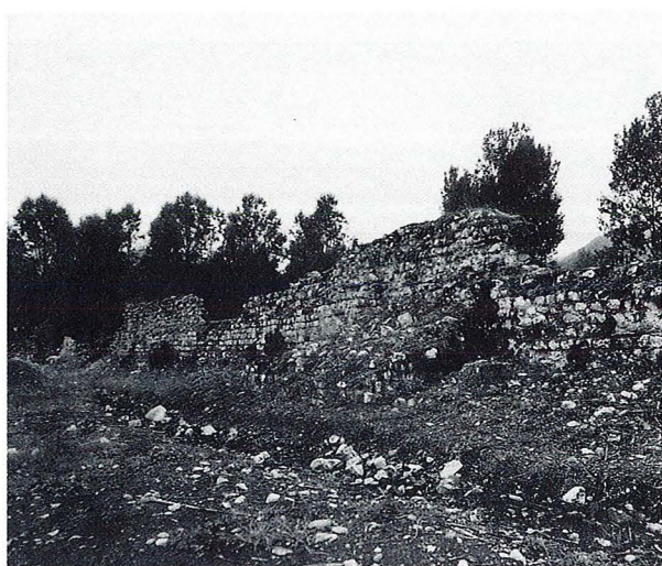
Fig. 5. — Mur d'enceinte ouest, vu de l'intérieur du camp. Au premier plan, talus et tour 2.
